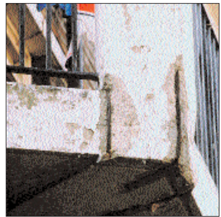
Spalling
