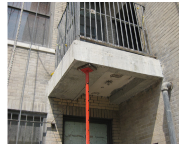
Sikacrete ® 211 SCC Plus for form and pour on a balcony.
