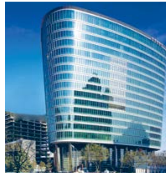
中海油大楼 北京
