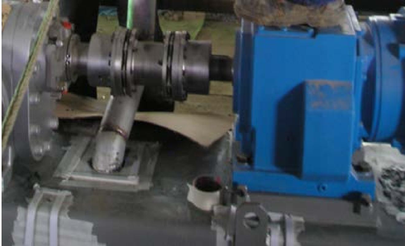
高位漏斗法灌浆
