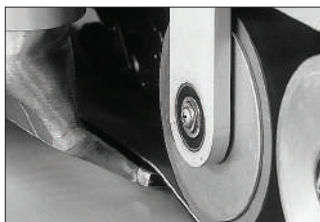
Soldadura de traslapeo con Sarnamatic
