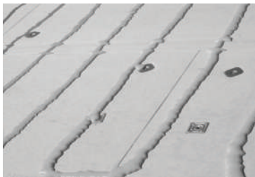
Patrón típico de instalación de espuma de poliuretano
