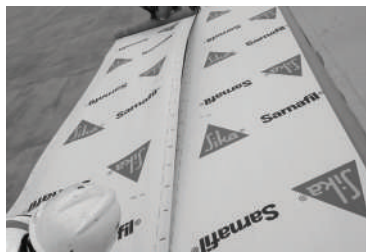
Vapor Retarder SA 31 colocado
