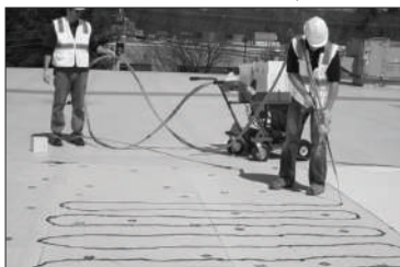
Aplicación con carretilla y manguera
