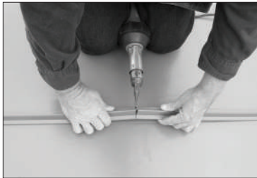
Fig. 1.1 Preensamblaje de perfiles Décor
