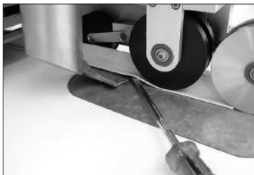
Fig. 1.8 Levantar el nervio para insertar la boquilla de la máquina Sarnamatic
