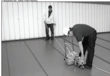
Fig. 1.9 Guiar la máquina Sarnamatic a lo largo de la línea correcta
