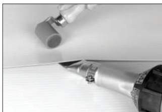
Presoldadura
