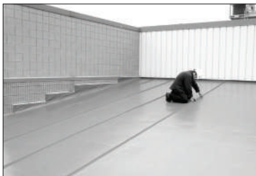
Fig. 1.4 Colocación de Décor sobre líneas de tiza
