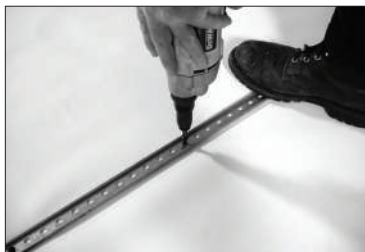
Instalación de sujetadores Sarnafastener
