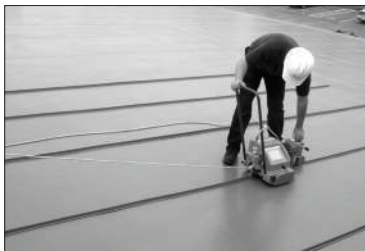
Fig. 1.5 Soga de seguridad atada firmemente a la máquina Sarnamatic
