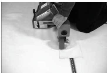
Soldadura de la tira de recubrimiento
