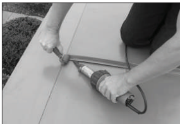
Fig. 1.10 Soldadura manual de Décor
