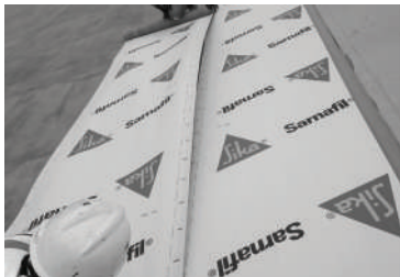
Vapor Retarder SA 31 laid in place
