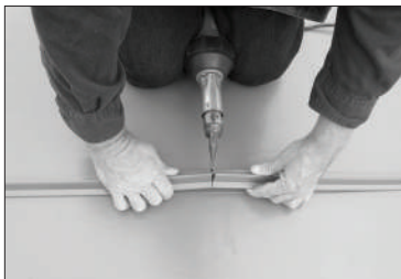
Fig. 1.1 Preassembling Décor Profiles
