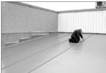
Fig. 1.4 Laying out Décor on the chalked lines
