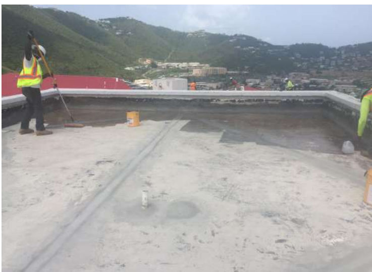
Sika Concrete Primer Lo-VOC polyurethane primer application on concrete deck.
