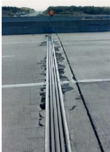
■ Header / Spalling
