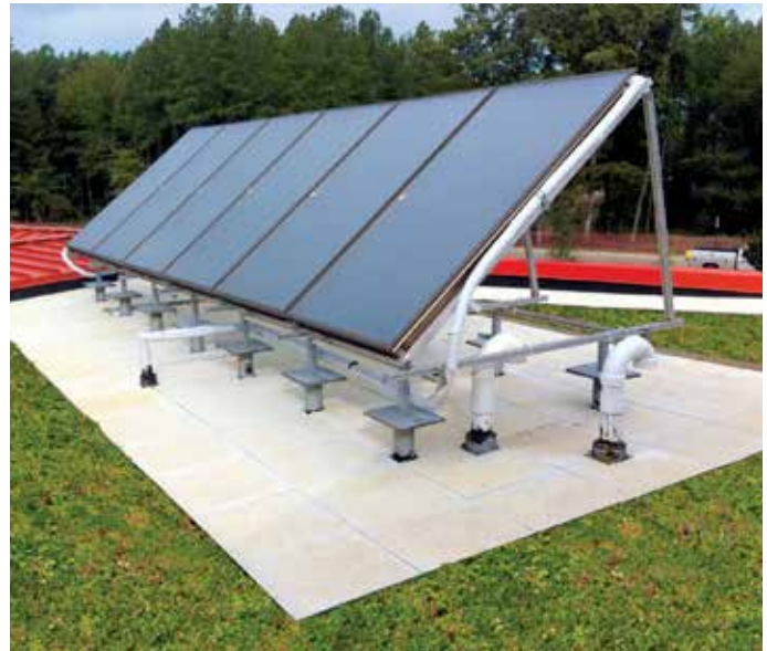
Fort Belvoir Dental Clinic - Fort Belvoir, VA
